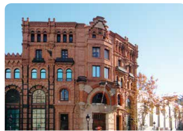
Renovierung, die Altes und Neues miteinander verbindet: alter Gebäudeteil neu saniert
